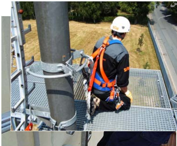
شکل ۱۱۱ - سامانه محدود کننده با استفاده از ریل
