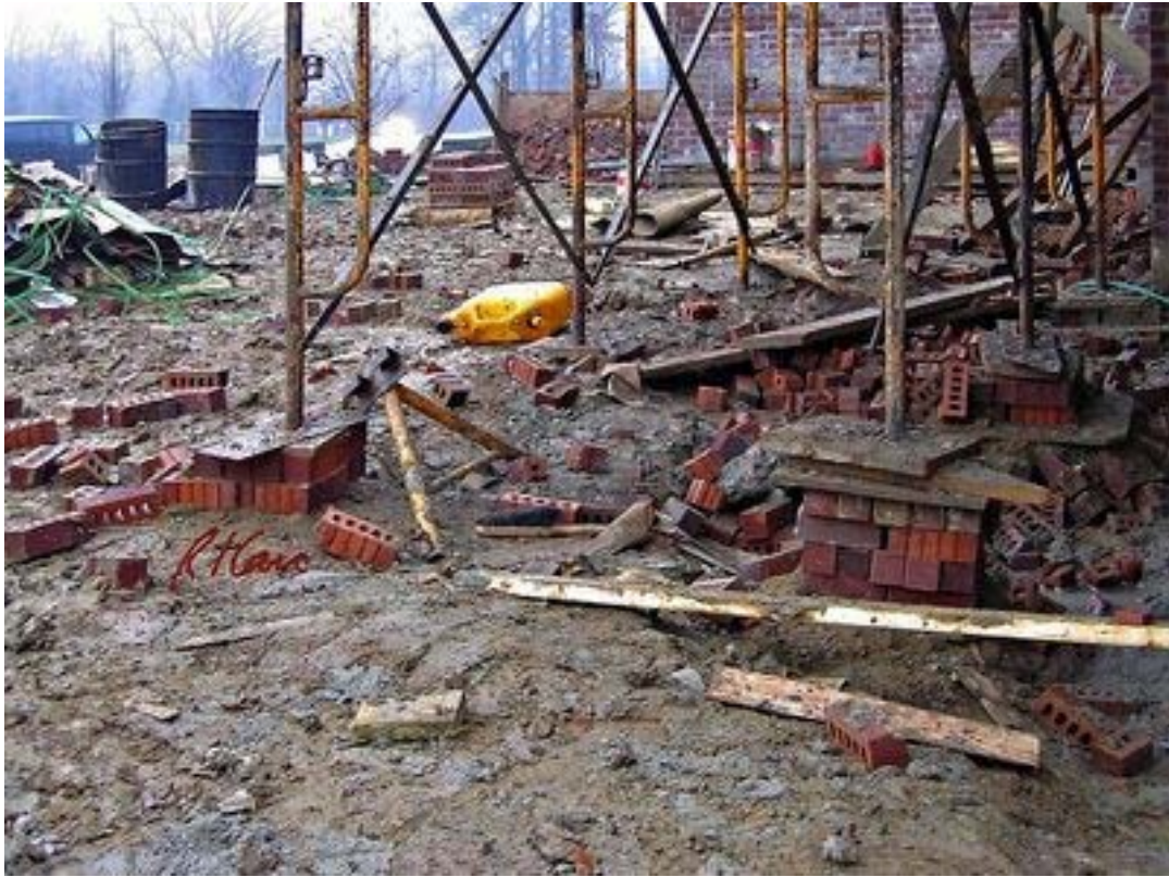
رفتار نایمن در نصب پایه های داربست
