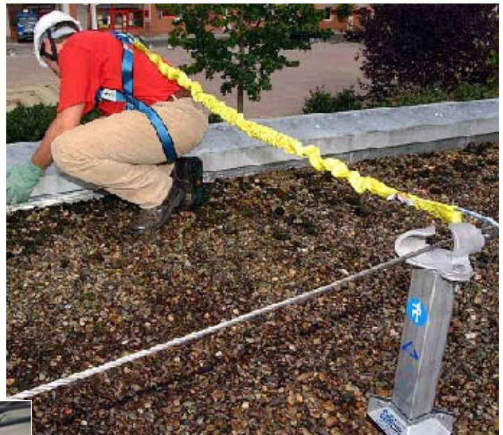
شکل ۵۴-۲- محدود کننده با اتصال یک طناب
