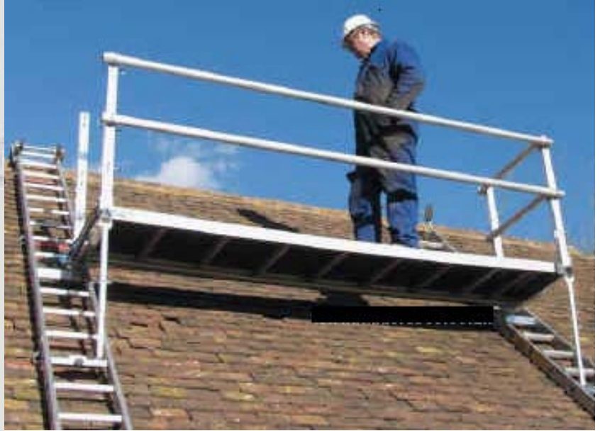
شکل ۳۰- جایگاه کار روی سطوح شیبدار
