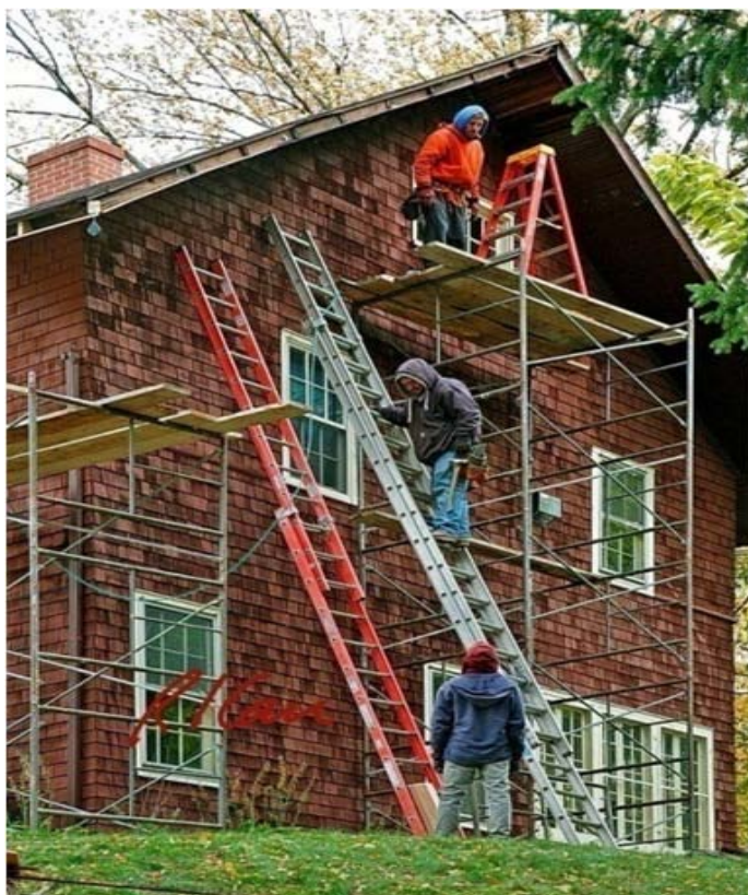
شکل ۲۷- تکیه استقرار نردبان در شیب زمین
